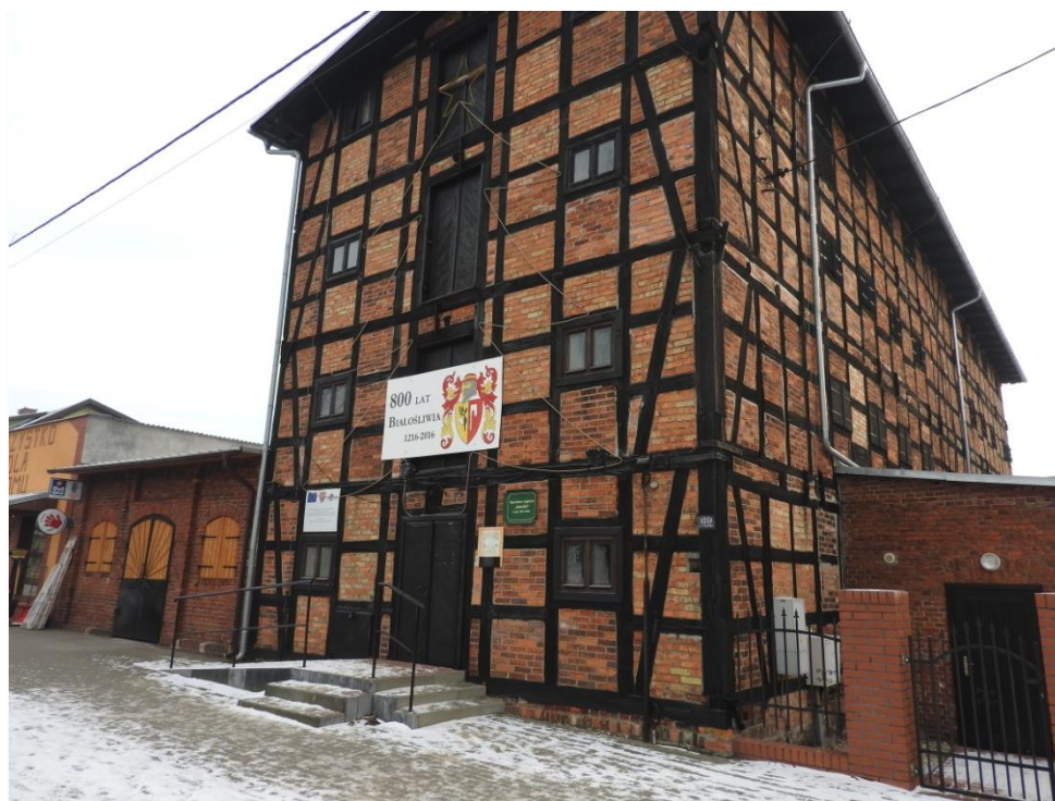
Fot. Spichlerz „Wacek” o konstrukcji ryglowej
