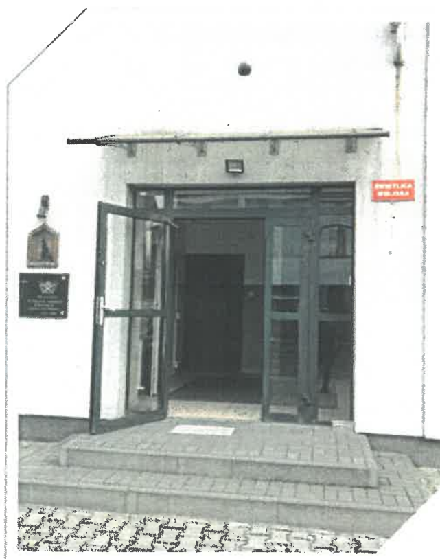
Budynek remizy i świetlicy wiejskiej
