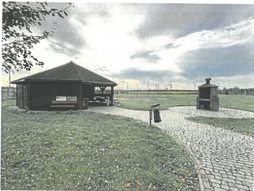
Wiata przy świetlicy
