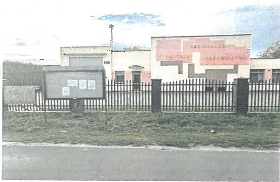
Budynek Regionalnego Centrum Sadowniczego oraz Remizy OSP
